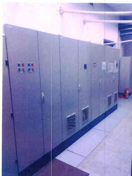
Frekvenču pārveidotāju barošanas spēku skapji
