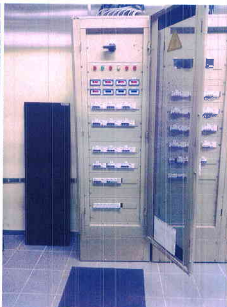
Elektroapsildes vadības skapis KTA-3 telpā
