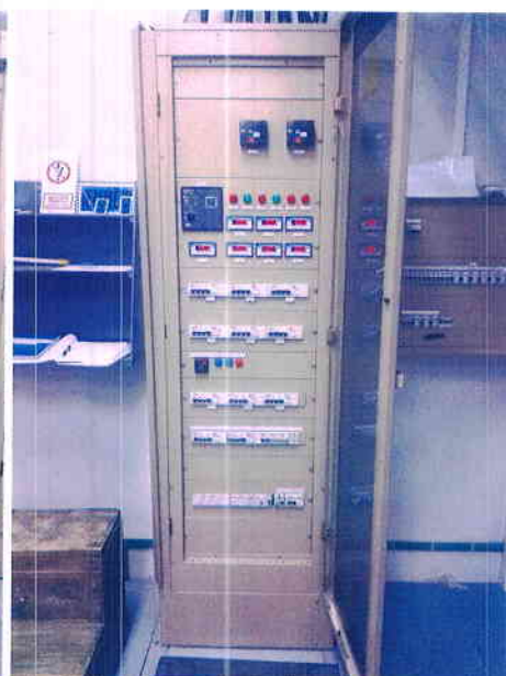
Elektroapsildes vadības skapis KTA-4 telpā
